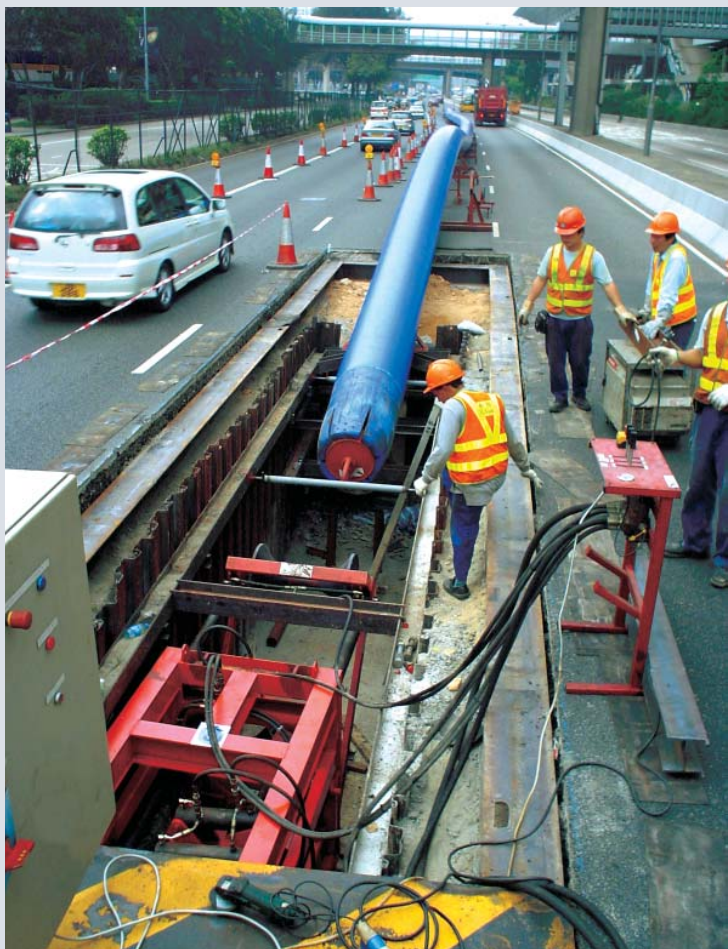
在15年內更換及修復長約3,000公里的老化水管，採用先進的無開掘技術，以減少工程對公眾和交通的影響
