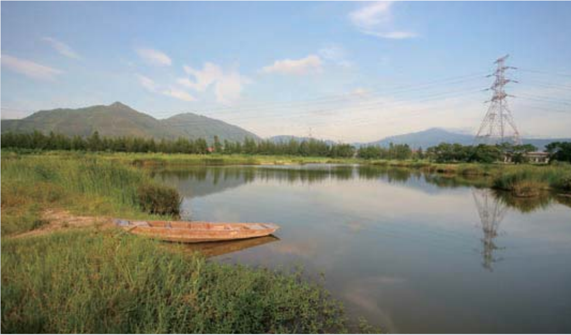
位於元朗排水繞道的人工濕地
