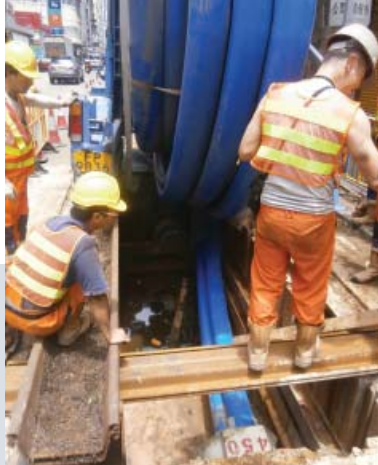
在吐露港公路進行水管修復工程
