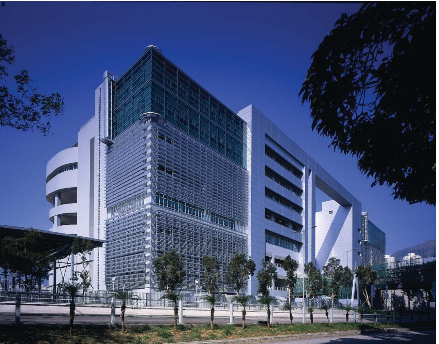
機電工程署總部大樓是一項於2005年完成的改建再用項目，並於2016年獲頒發綠建環評既有建築白金獎
