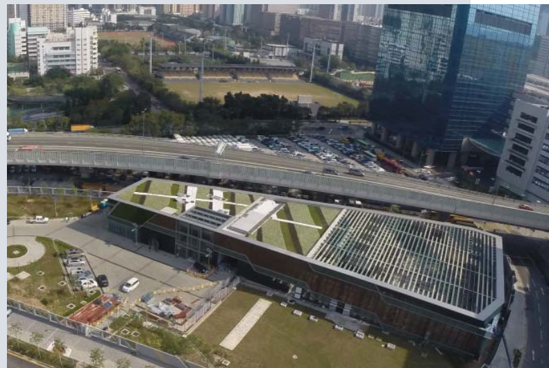
啟德發展區的區域供冷系統
