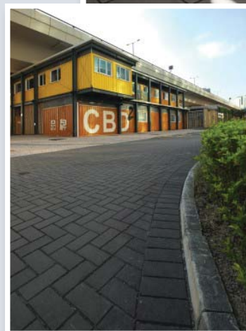
使用再造材料製成的鋪路磚
