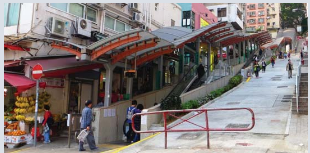
西營盤正街自動扶梯連接系統
