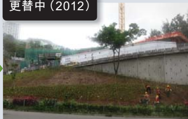
在現場進行更替種植工程
