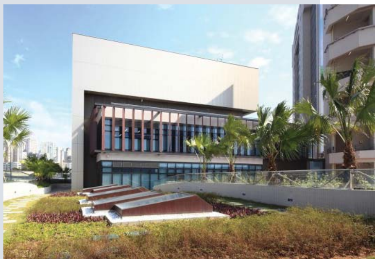
啟德消防局榮獲綠建環評新建建築白金獎
