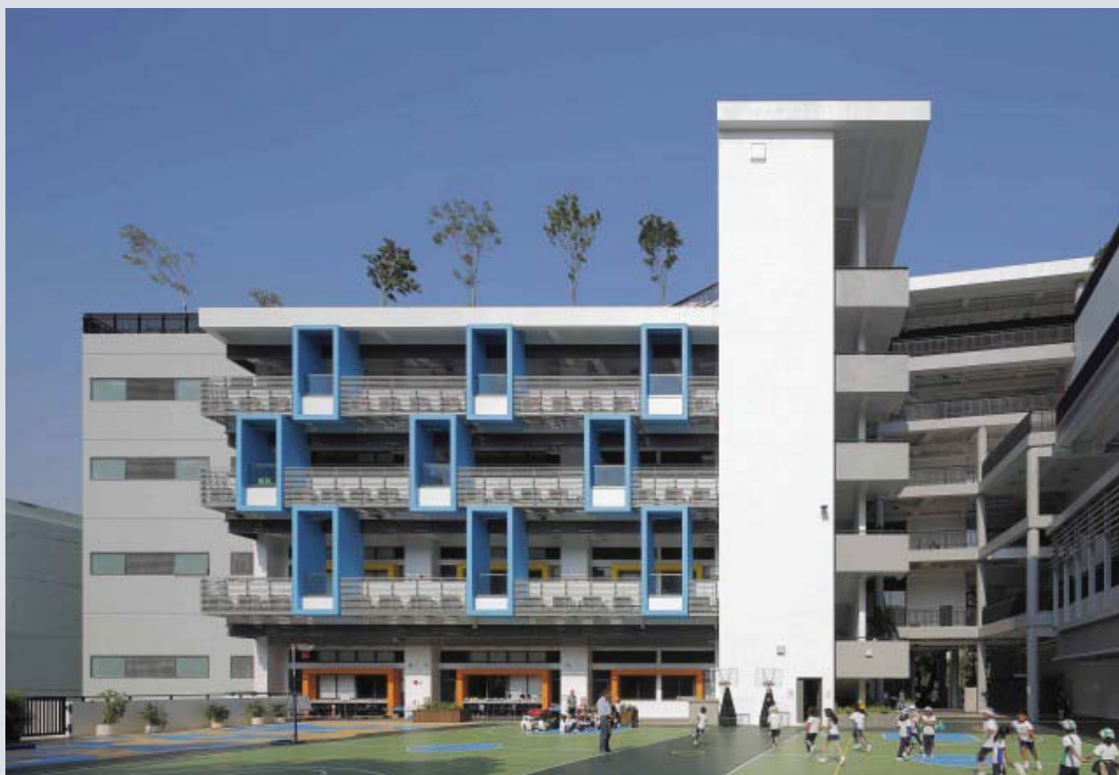
重建的九龍小學獲頒發綠建環評新建建築證書
