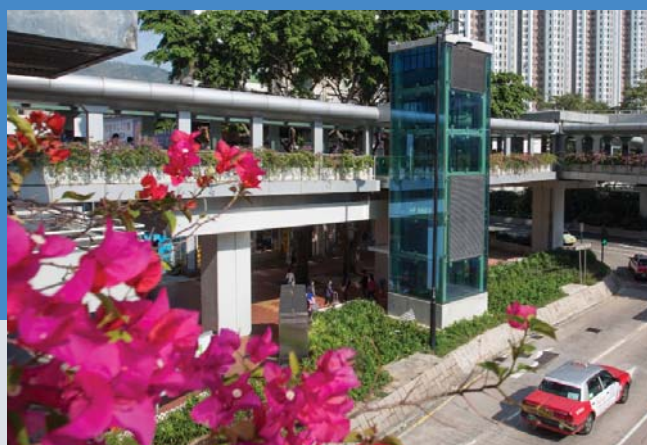
在荃灣南豐中心附近、橫過青山公路的行人天橋安裝了電梯
