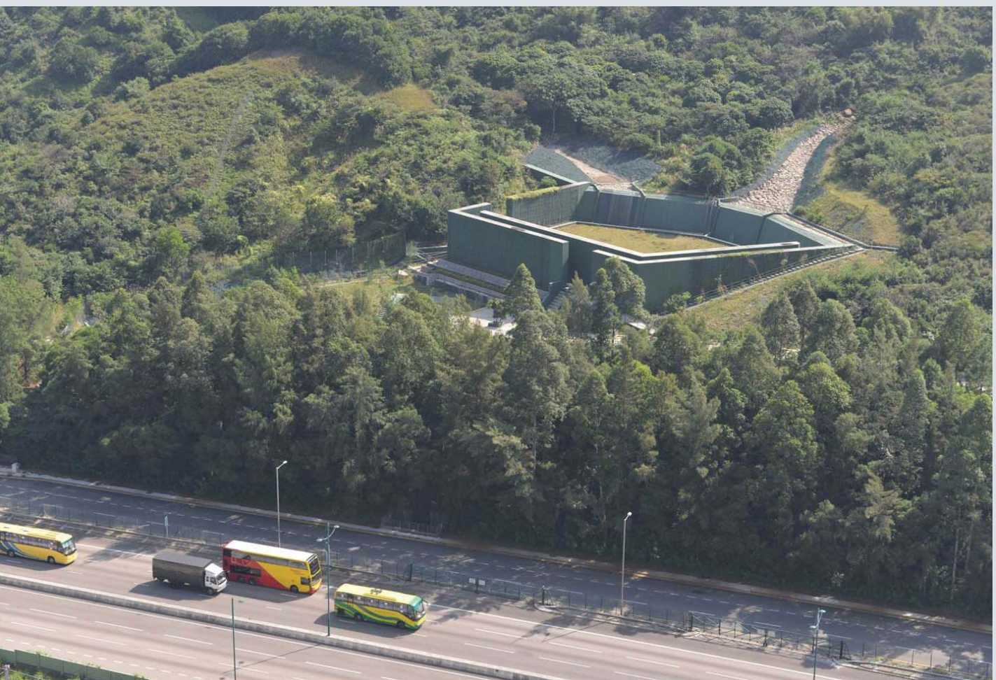
保護通往機場的主要道路（北大嶼山公路）的隔泥石屏障，防止泥石流
