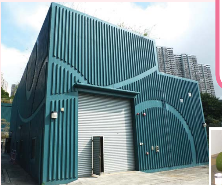
海水配水庫及高地配水系統
